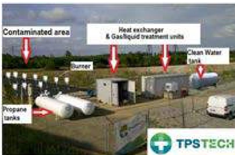
Figure 3- Mise en œuvre ex-situ on site du procédé GTR™ : unité de chauffage et unité de traitement de la vapeur récupérée
