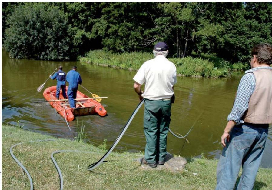
**À partir d'une barque, le tuyau de polyuréthane, lesté par un câble d'acier enrobé de même matière et soudé, est déroulé directement sur le fond.**
