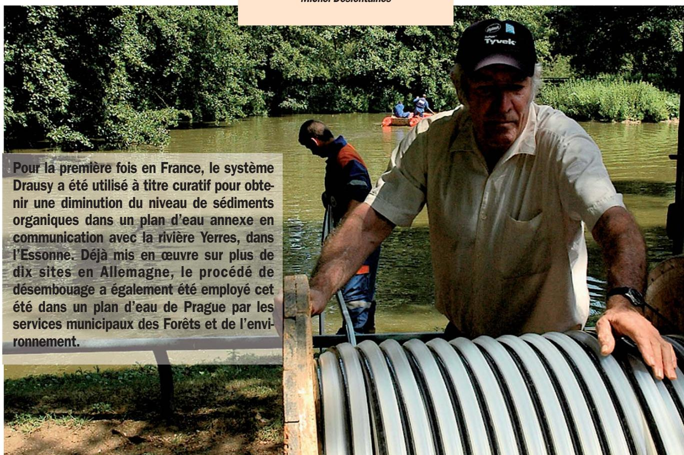
Pour la première fois en France, le système Drausy a été utilisé à titre curatif pour obtenir une diminution du niveau de sédiments organiques dans un plan d'eau annexe en communication avec la rivière Yerres, dans l'Essonne. Déjà mis en œuvre sur plus de dix sites en Allemagne, le procédé de désembouage a également été employé cet été dans un plan d'eau de Prague par les services municipaux des Forêts et de l'environnement.
